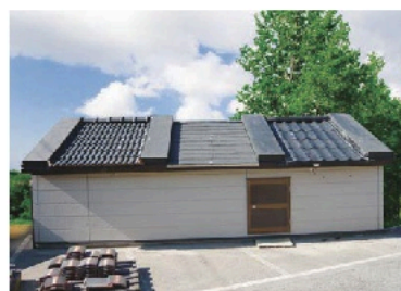
小屋裏温度実験棟
